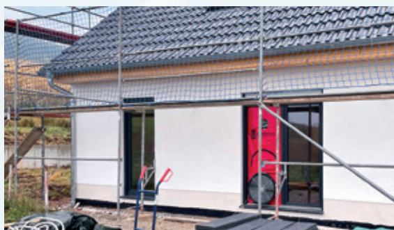
Misurazione BlowerDoor in un edificio di nuova costruzione
